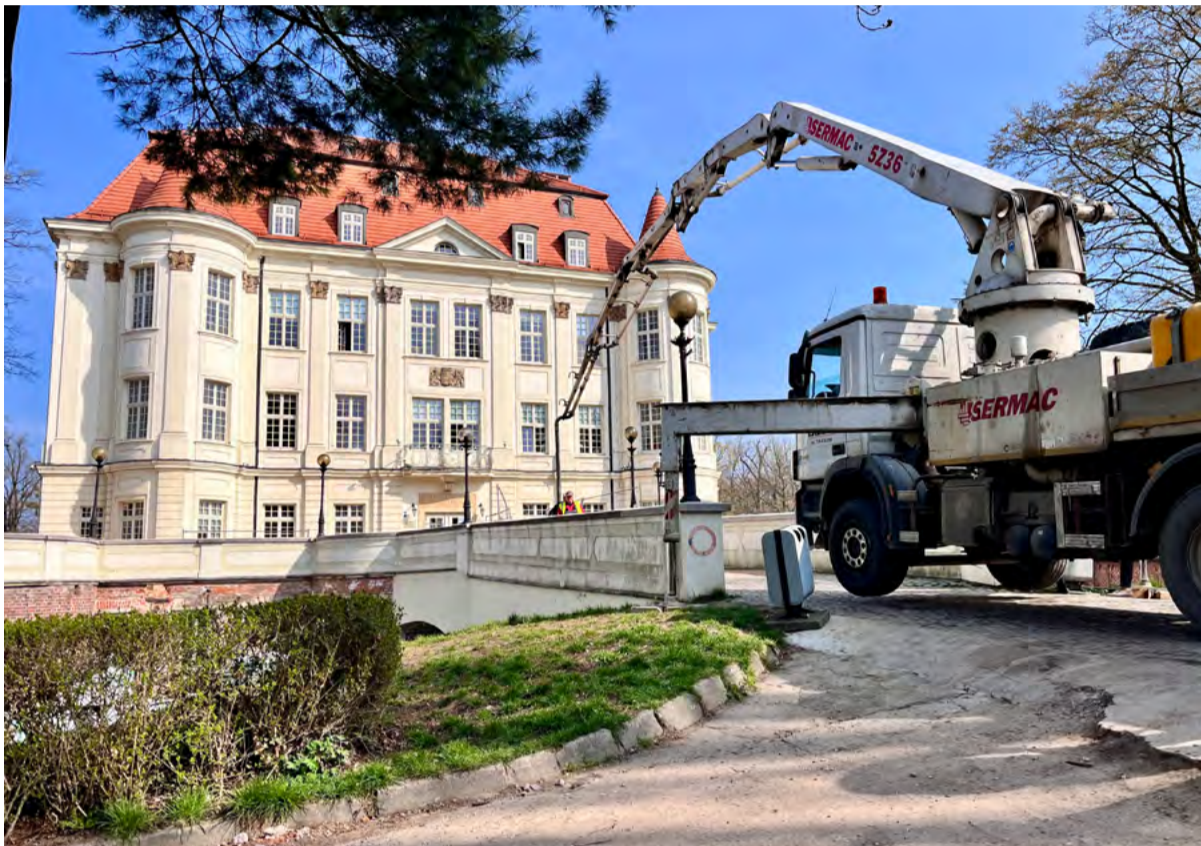
Prace remontowe przy siedzibie OPT Zamek / fot. OPT Zamek
