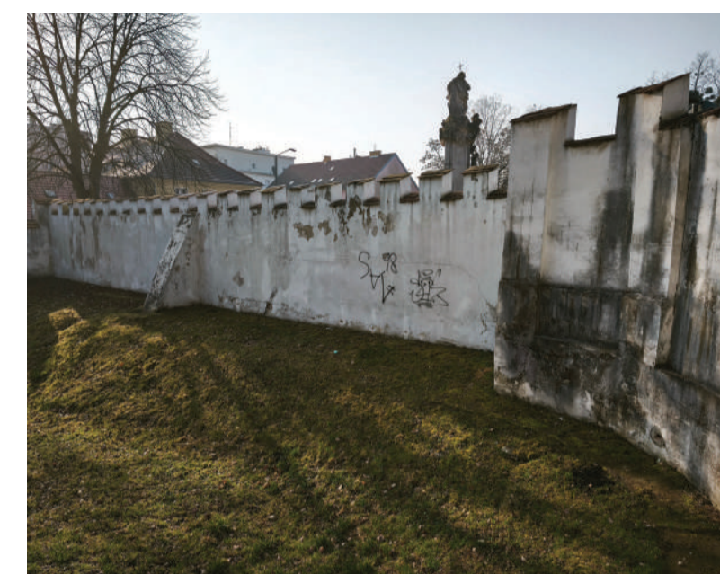
Mur przy Leśnickim Zamku / fot. Paweł Kamiński
