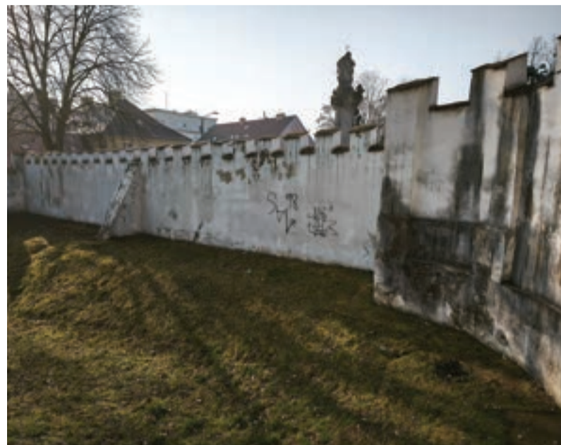
Mur przy Leśnickim Zamku / fot. Paweł Kamiński
